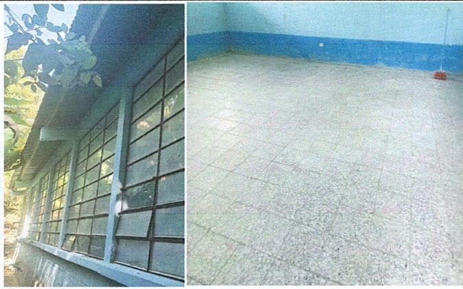
Foto 1: CAMBIO DE PISO Y VENTANAS
