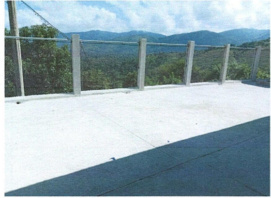
Foto 2: REPARACIÓN DE CERCO O MURO PERIMETRAL
