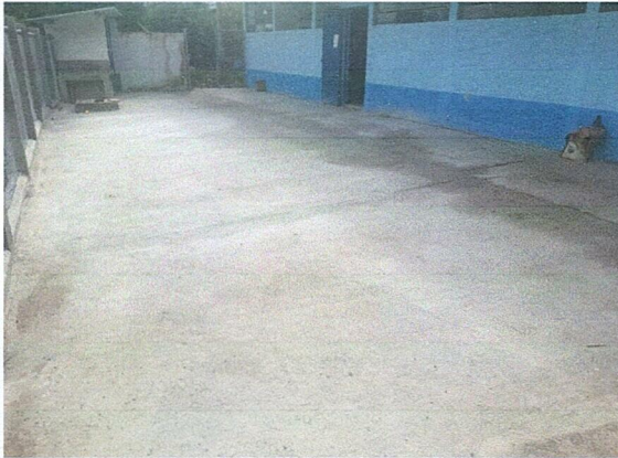
Foto 3: REPARACIÓN DE LOSA DE PATIO
